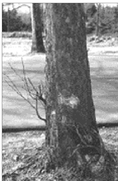
Figura 4 - Danneggiamenti al tronco e alle radici in seguito all'apertura di un cantiere stradale. (Foto E. GERVASINI)
