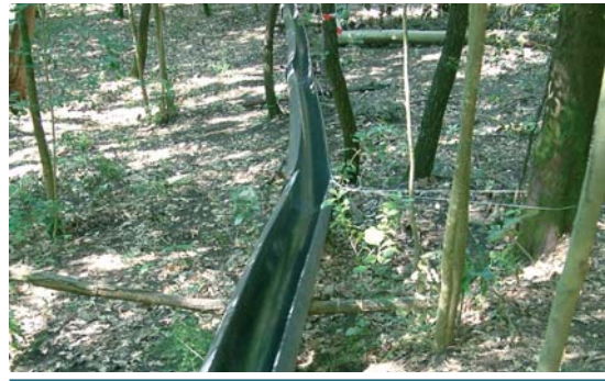
Foto 75 Canalette in polietilene
